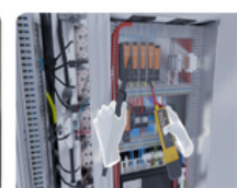
Trabajos en Media y Alta Tensión
